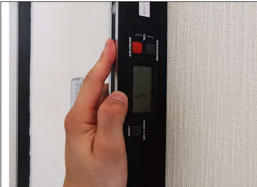
Фото №4. Измерение уровня стен в коридоре.
