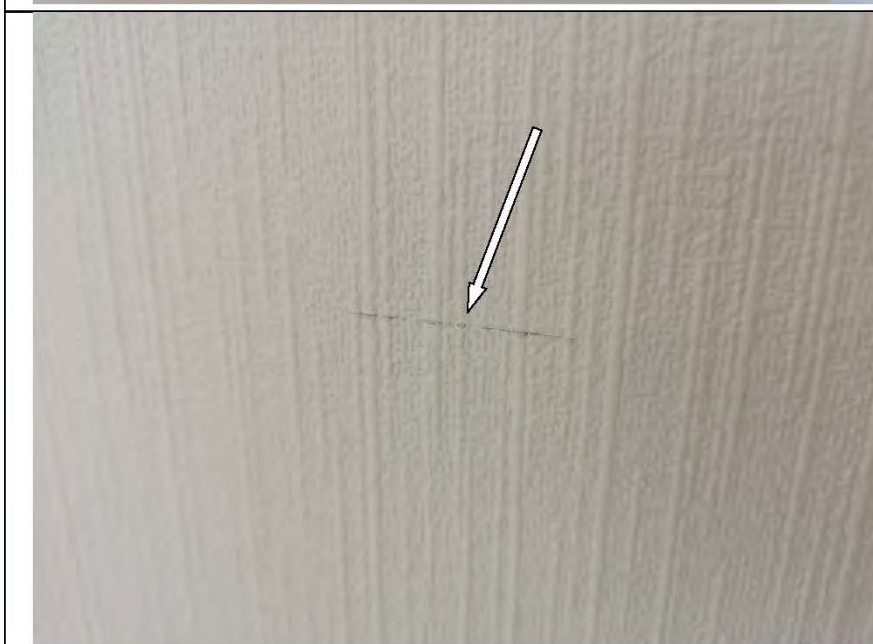
Фото №9. Потертости обойного полотна в комнате.
