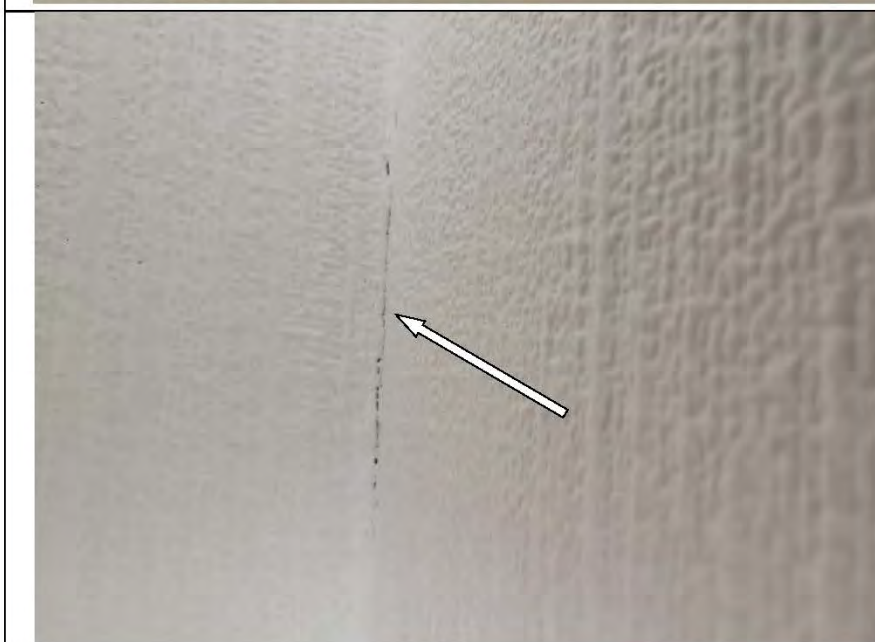
Фото №11. Читаемые обойные стыки в комнате.
