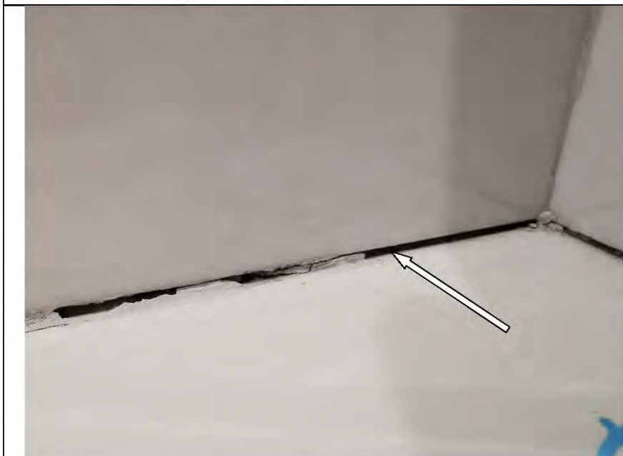
Фото №14. Неполное заполнение шовного пространства настенной керамической плитки затирачным составом в ванной комнате.
