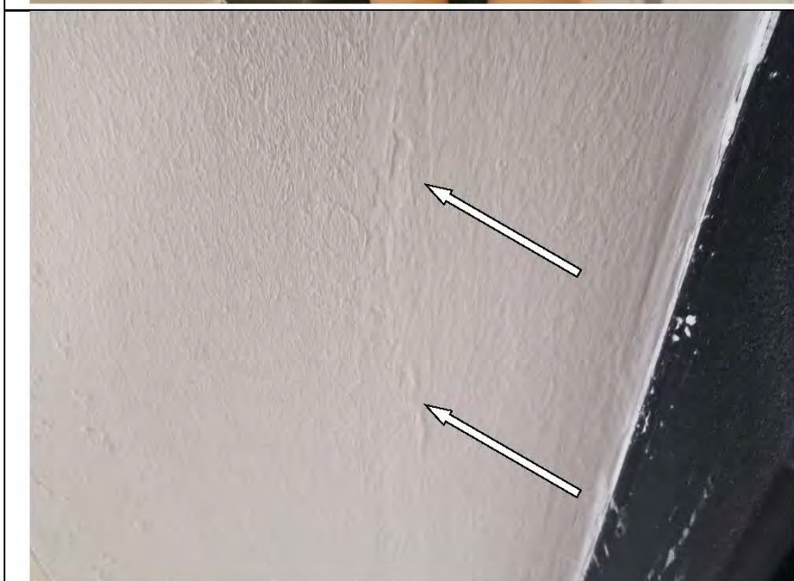
Фото №42. Царапины на коробке входного дверного блока.
