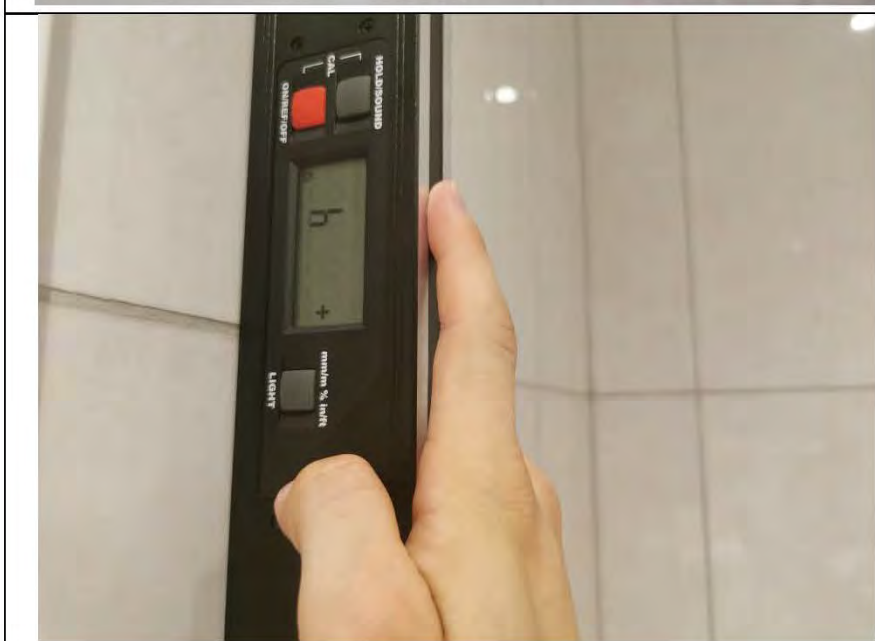
Фото №12. Измерение уровня стен в ванной комнате.
